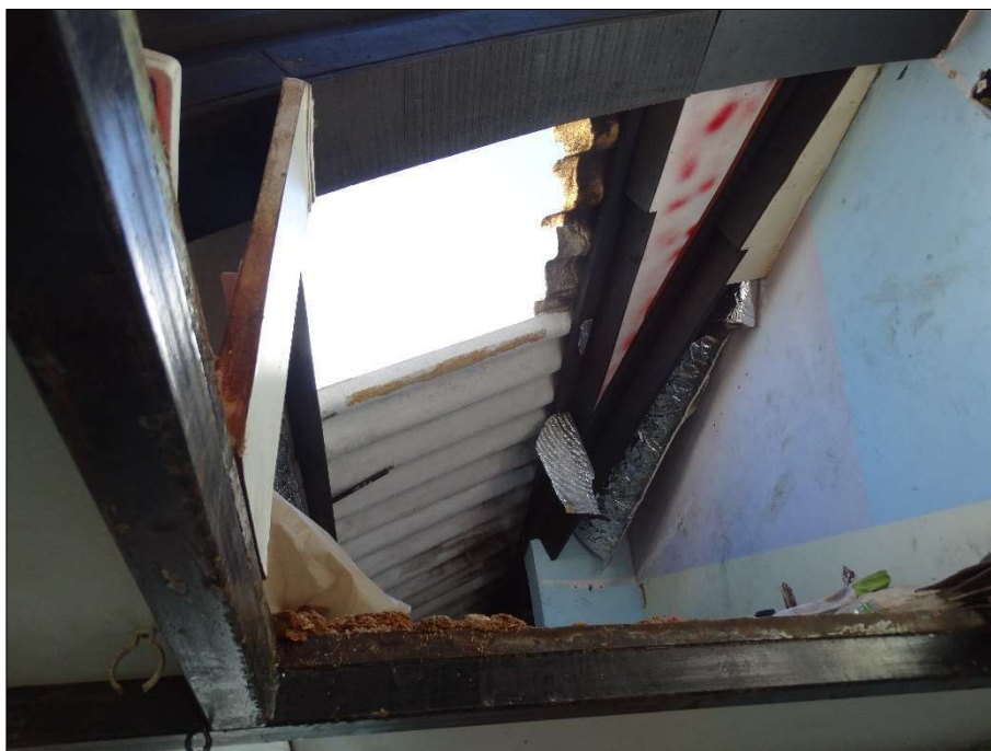
Figura 6 - Telhas removidas.
