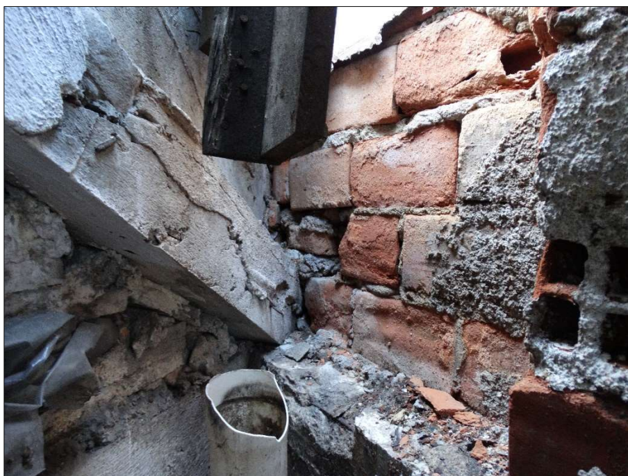
Figura 13 - Alvenaria deteriorada.
