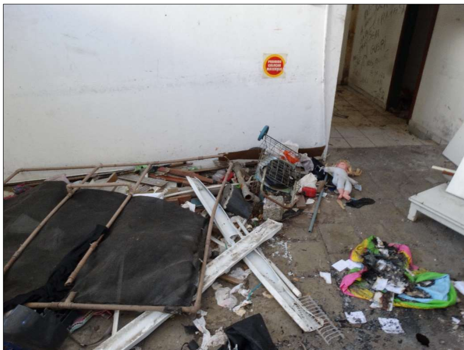
Figura 4 - Acúmulo de resíduos.
