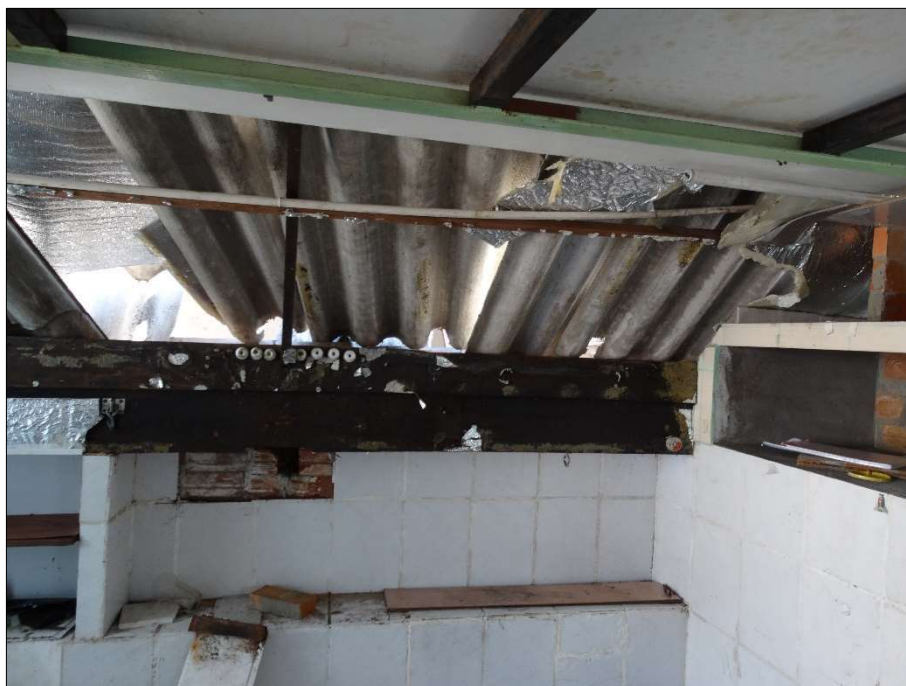
Figura 7 - Telhas quebradas.
