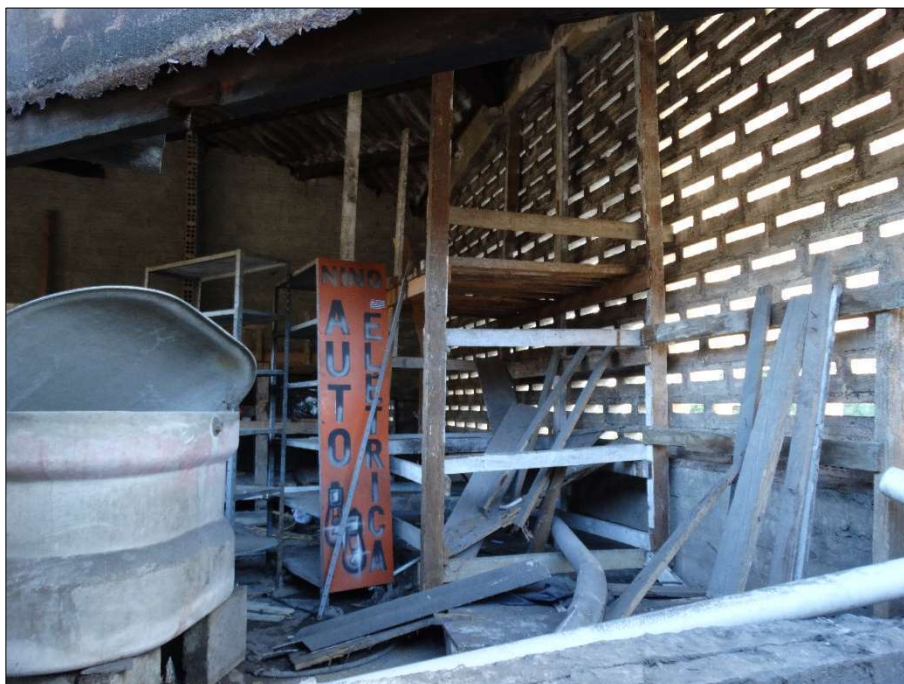
Figura 10 - Cobertura danificada.
