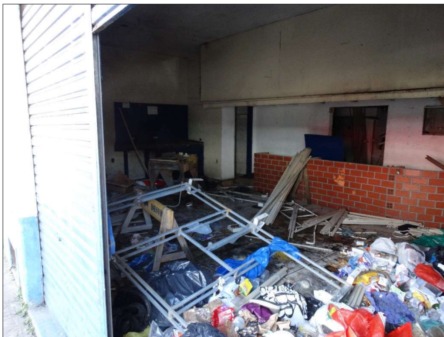
Figura 3 – Acúmulo de resíduos.
